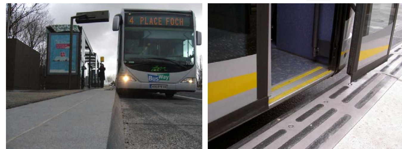
Figure 14 : Accostage et accessibilité sur le BHNS de Nantes (Busway)-chaussée béton, bordures de guidage biaises et polies
